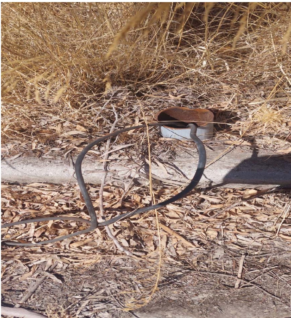
Φωτογραφία 12: Κομμένος Ιστός φωτεινής σηματοδότησης με καλώδια ρεύματος και χωρίς φρεάτιο έλξεως καλωδίων .
