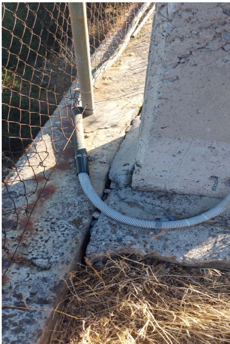
Φωτογραφία 8: καλώδιο σε σωλήνα ύδρευσης
