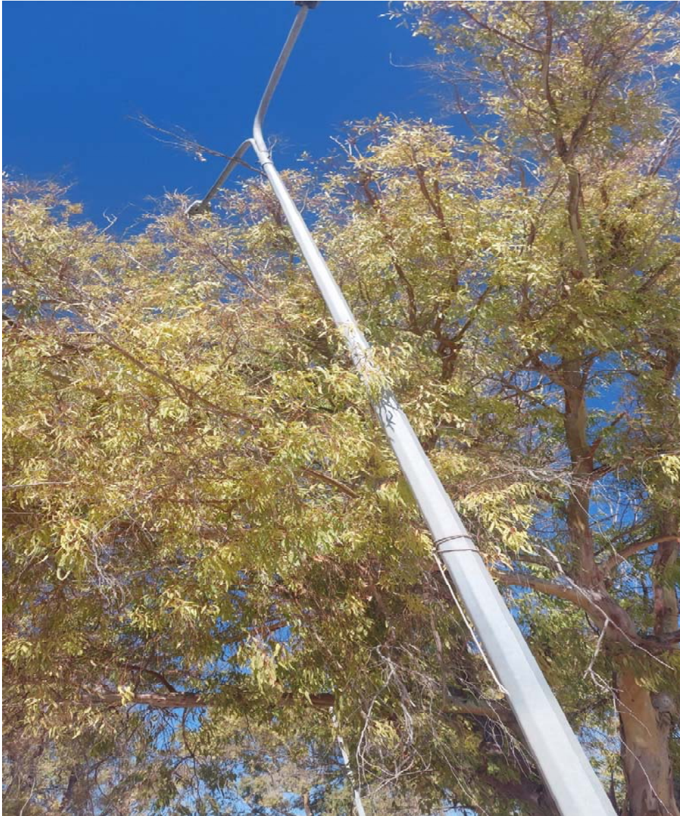
Φωτογραφία 1: Ιστός φωτισμού με δυο βραχίονες και φωτιστικά με λάμπες Νατρίου
