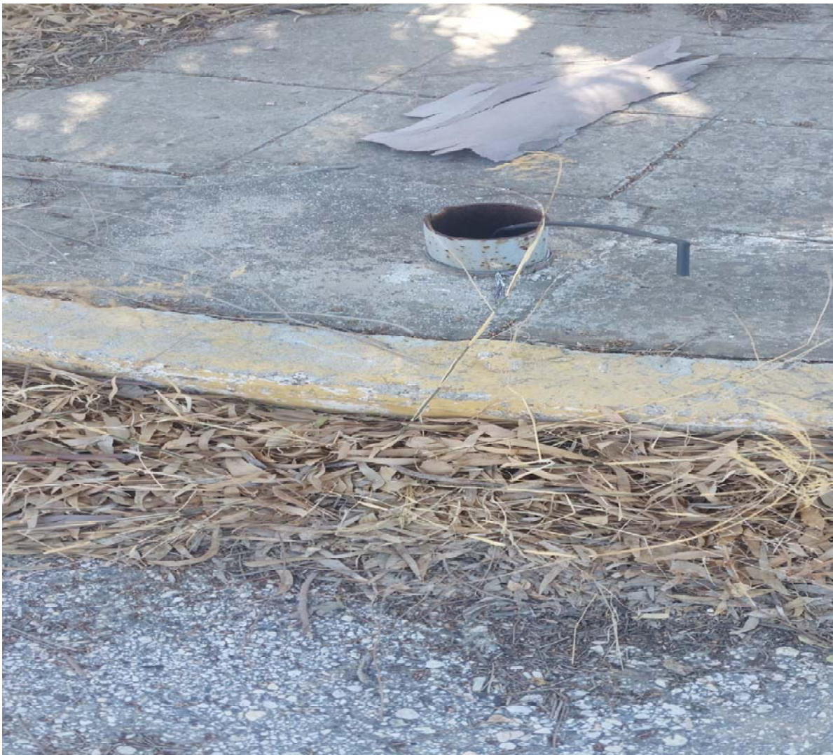
Φωτογραφία 11: Κομμένος Ιστός φωτεινής σηματοδότησης με το κομμένο καλώδιο ρεύματος και χωρίς φρεάτιο έλξεως καλωδίων
